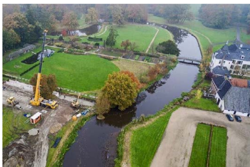
aanleg vispassage november 2015
